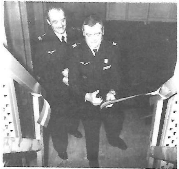
Inauguration de la plateforme ERT 10.05.1986
